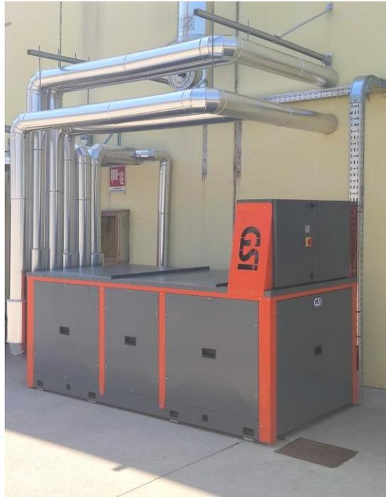
**AQUA FOUR** è la pompa di calore di tipo geotermico progettata per qualsiasi tipo di applicazione, dal complesso residenziale fino allo stabilimento industriale dove è richiesta un'elevata potenza termica. La speciale configurazione con **DOPPIO CIRCUITO FRIGORIFERO INDIPENDENTE** assicura il 50% del funzionamento, grazie alla totale separazione dei compressori, in caso di allarme o di guasto di uno di essi.
