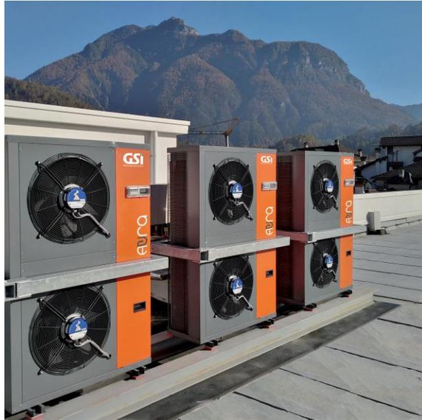
**AURA** è la pompa di calore monoblocco di installazione semplice, ampio range di potenza e funzionamento efficiente. Progettate per l'installazione in edifici residenziali e commerciali di piccola taglia, le unità AURA possono essere abbinate a impianti di climatizzazione radiante, a tutt'aria o misti. Su richiesta, le unità AURA possono essere equipaggiate con la tecnologia MAGIS per il recupero di calore del compressore e produzione di acqua calda sanitaria tramite bollitore esterno.
