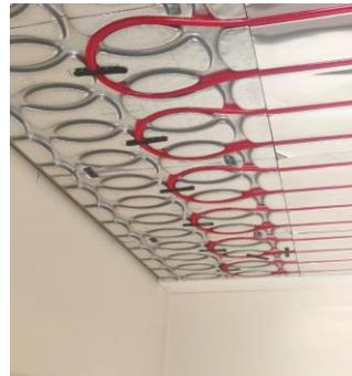
L'innovativo sistema modulare a soffitto/parete KLIP proposto da G.S.I. rivoluziona il concetto di installazione dei sistemi a soffitto e parete attraverso la posa in opera delle tubazioni eliminando raccordi sotto pannello di finitura a vantaggio di una maggiore flessibilità in fase esecutiva. Facile, leggero e sicuro, KLIP non ha raccordi di connessione tra i pannelli, azzerando potenziali rischi di perdite d'acqua anche future.
